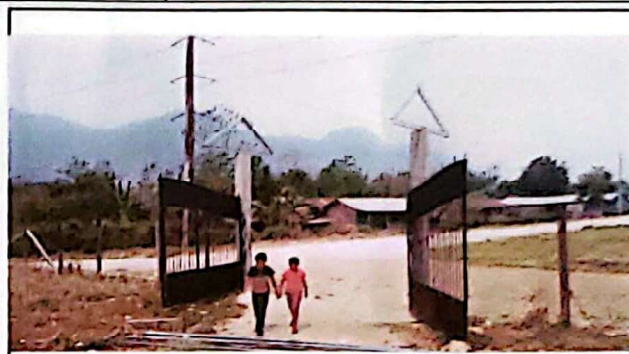
se observan los trabajos ya iniciados en la reparacion del porton
