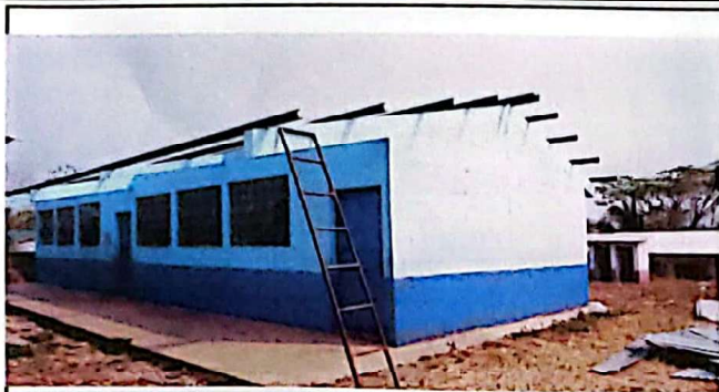
se observa el cambio de techo que se esta realizando en el establecimiento
