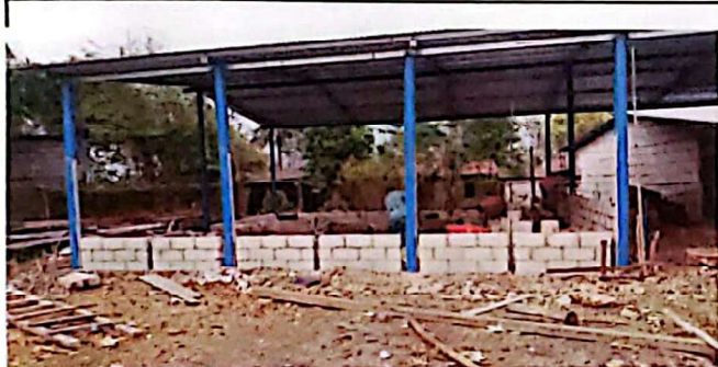
Sustitucion de paredes de cocina.
